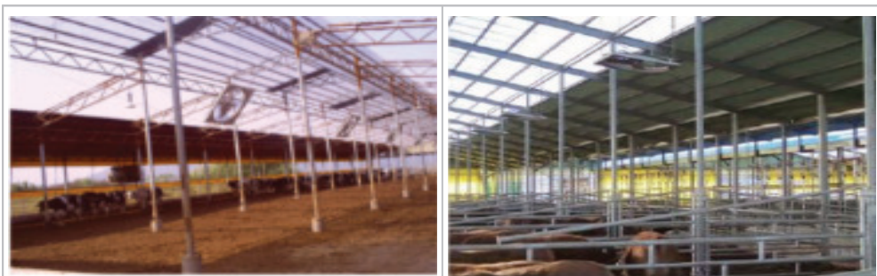
그림 10. 우방 내 송풍팬 위치(수직 0^\circ (좌), 기울기( 45^\circ 우)
