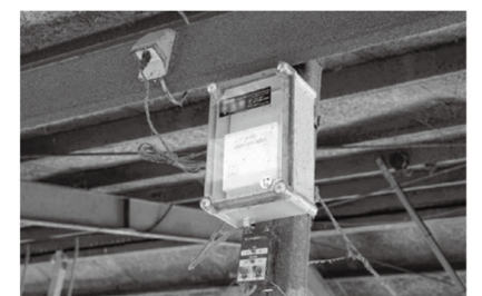
[우사천정 설치 분만감시 시스템 통신기]
