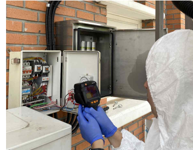
<열화상카메라를 이용한 배전반 점검 모습>
